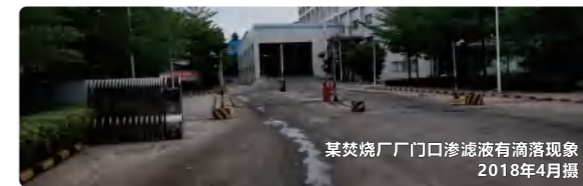
某垃圾焚烧厂门口渗滤液有滴落现象，2018年4月摄
