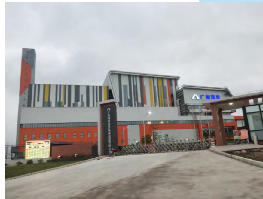
广州环投南沙环保能源有限公司大门在厂区门口公开自动监测数据
